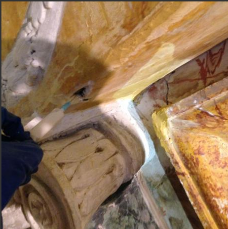
Consolidamento con iniezione
